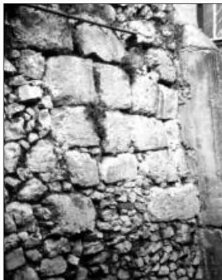
Fig. 6. Muro di sostruzione in opera quadrata presso il civico 69 dell'attuale via Valeria
