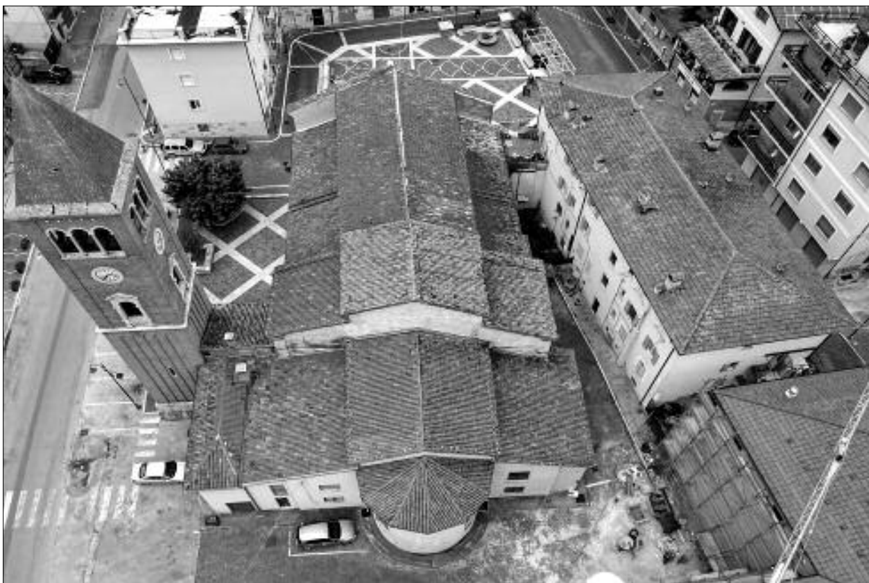
Foto 6. Carsoli, chiesa di Santa Vittoria, veduta aerea (foto: Antonello Arcangeli)
