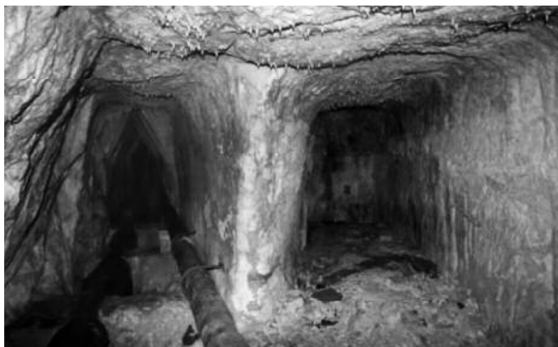
Accesso della galleria a monte
