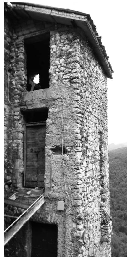
**Fig. 3b.** Resistenza secolare per cementazione di un edificio pur se fatiscente dovuto al legame chimico monolitico fra la calce da grassello e la pietra calcarea.
