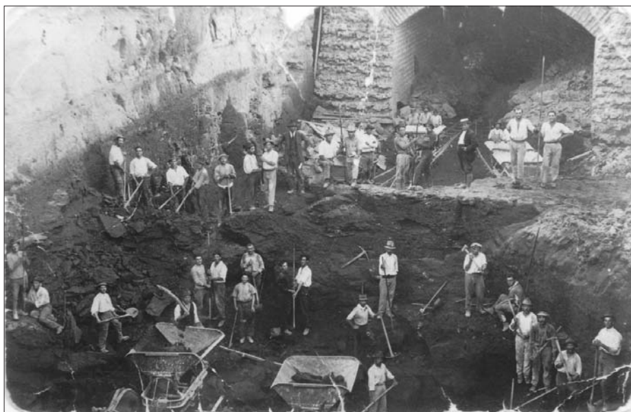
Fig. 5. Cantiere in Abruzzo.
