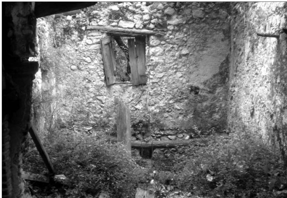
Fig. 3. Un interno del casolare.
