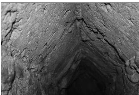
Dall'alto verso il basso: l'acquedotto allo sbocco sulla sponda del torrente; dopo aver percorso circa 15 m verso l'interno; la volta. Il manufatto, almeno nella parte da noi esplorata, è formato da materiale cementizio gettato in casseformi in legno, ancora sono visibili le impronte delle tavole. Le misure prese all'imbocco del tunnel sono: altezza 145 cm, larghezza 37 cm, azimut del tratto iniziale 120°.
