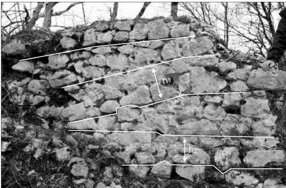
Fig. 26. Santa Maria di Luppa, disposizione dei filari all'estremità ovest del muro meridionale della chiesa, le linee bianche ne evidenziano l'andamento;  $h_1 = \text{cm } 34$ ,  $h_2 = \text{cm } 25$ .
