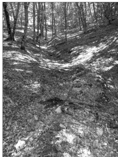
Fig. 6. La piccola traversa nella parte elevata della Valle Moscosa, destinata a "invitare" l'acqua a defluire nel canale adduttore, che giunge poi al vascone
