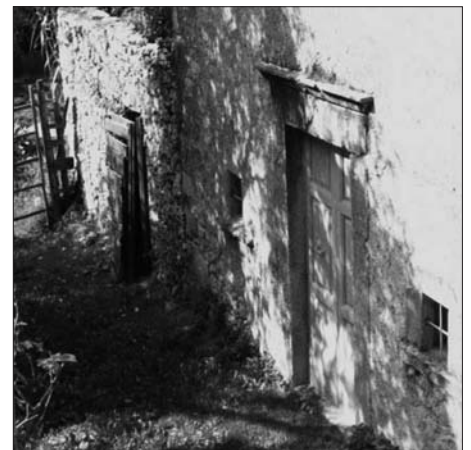
Fig. 6. Ingresso della chiesa, a sinistra il vecchio cimitero
