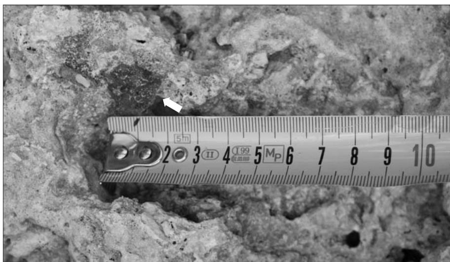
Fig. 9. Castello di Luppa, particolare della malta, la freccia indica un frammento di coccio pesto
