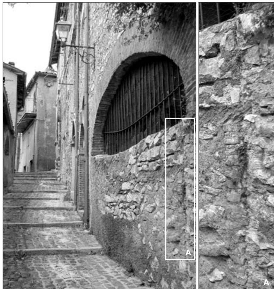
Fig. 3. Apertura a mezzaluna con indicato il particolare (A) dello stipite della vecchia porta
