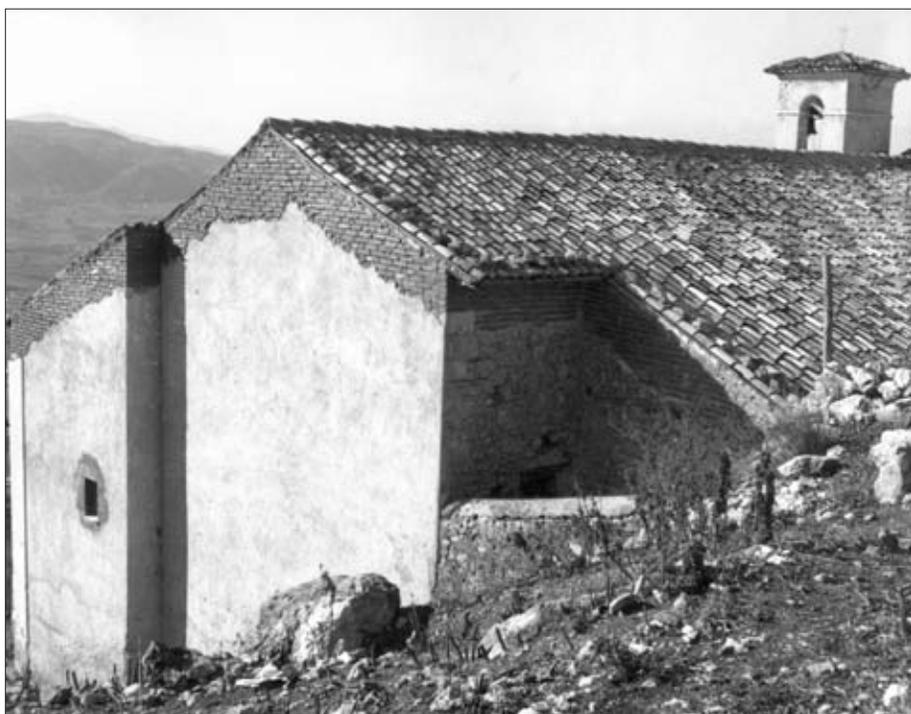
Figura 10. Soprelevazione con in basso a destra l'architrave di una finestra
