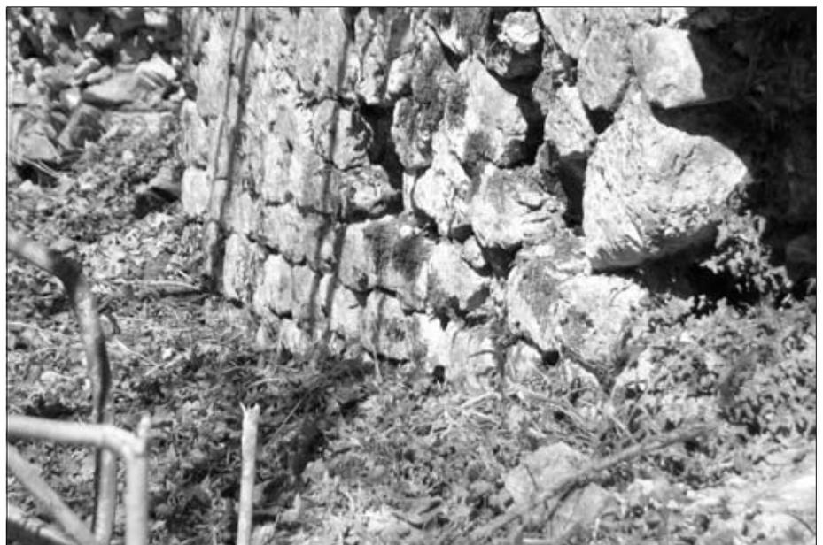
Fig. 6 Muro Pertuso, tratto con base formata da tre file di blocchetti calcarei
