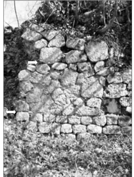
Fig. 8 Muro pertuso, tratto con base d'appoggio formata da tre file di blocchetti di calcare; le frecce bianche indicano i punti di ripresa del muro
