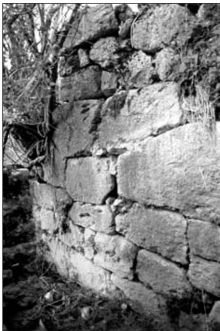
Fig. 5. *San Pietro*, muro in opera poligonale.
